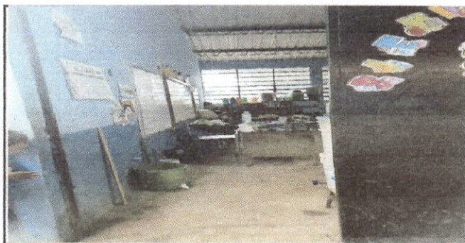
Foto 5: piso del aula 5 Primero B, se encuentra con agujeros y es de concreto rústico.
