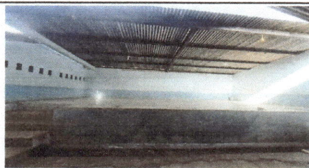
Foto 6: el escenario esta dañado al fondo por la colocación de pegamento, las gradas estan deterioradas.
